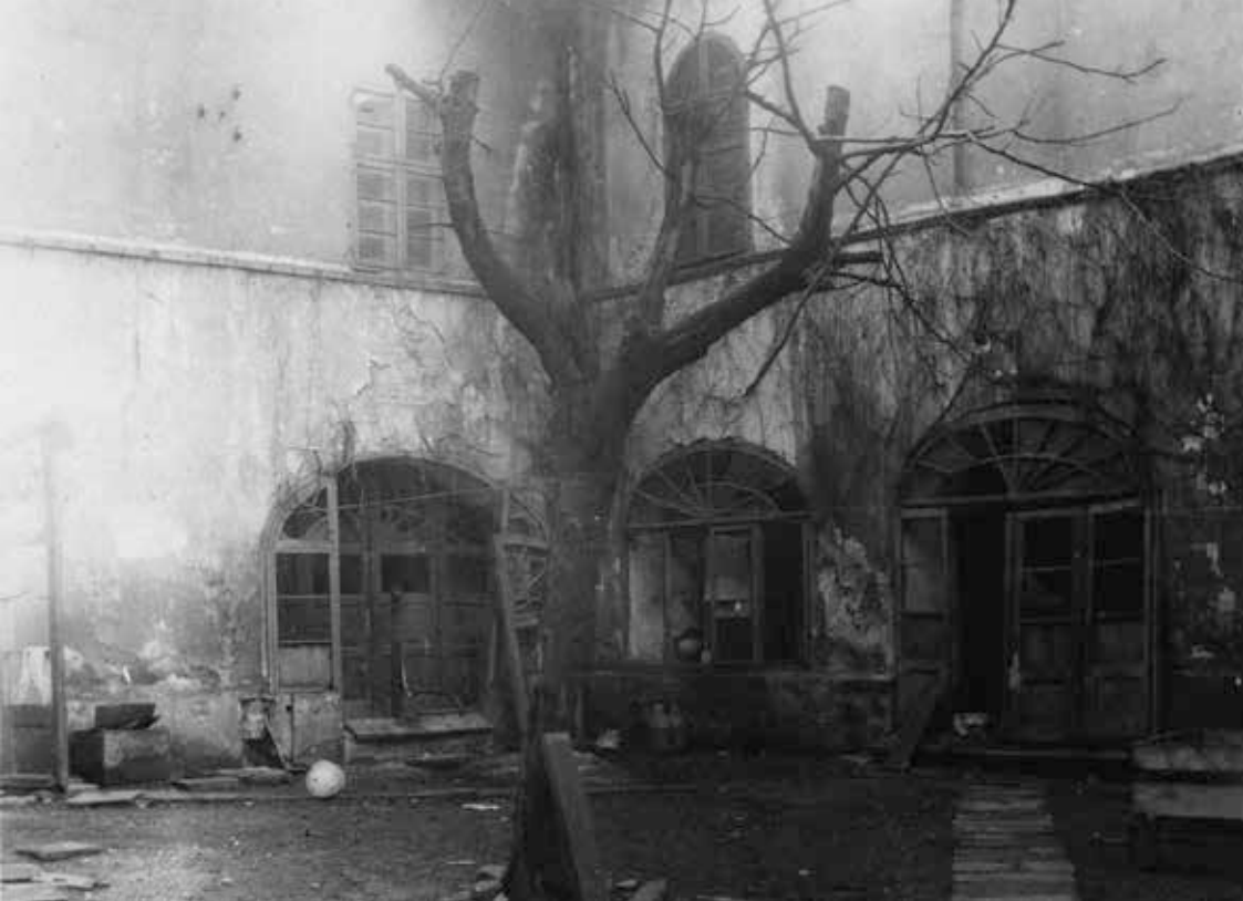
▲ Stav zámku před demolicí
