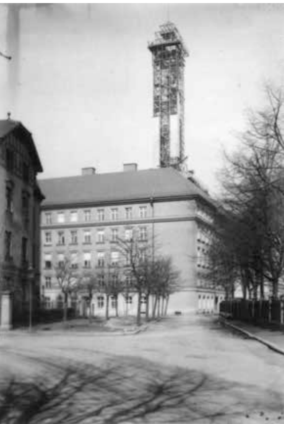
▼ Nová radnice, stavba věže, 1930
